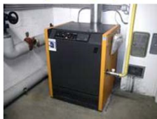
Schornsteinfeger stellen 1,3 Millionen Heizungsängel fest - hier: Heizungsöle in einem Hamburger Mehrfamilienhaus (Foto: energie-experten.org)
