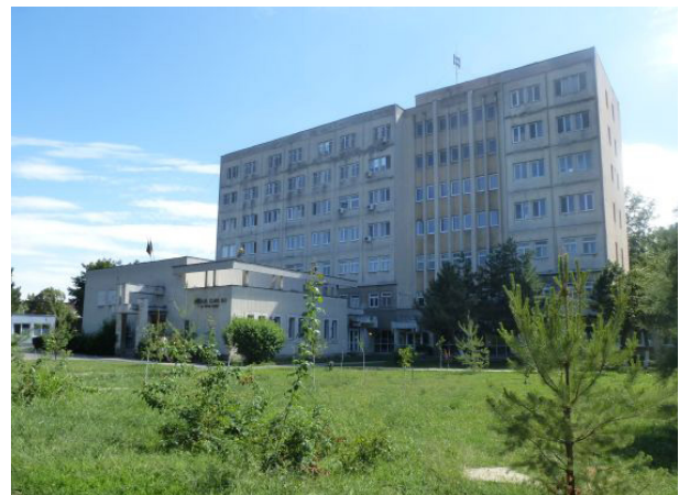
Unter Leitung der BEA wird ein Krankenhaus in Craiova (Rumänien) nach einem ESC-Modell energetisch saniert.
