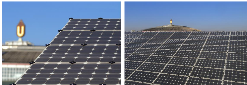
Solarmodule Westfalenhalle (Quelle: DEW21)
