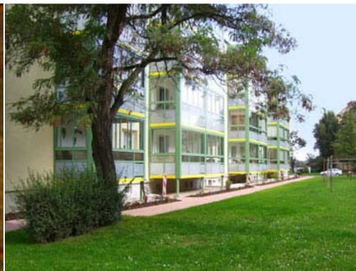
Projekt: Cofely, Lucka Foto: Cofely
