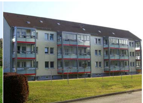
Projekt: Cofely, Mumsdorf Foto: Cofely
