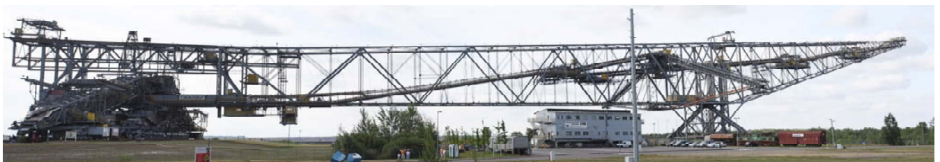
Beispiel einer Förderbrücke (hier: Förderbrücke F60 in Lichterfeld) Foto: flickr.com, blackpictures
